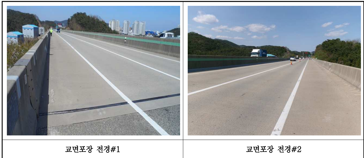
【사진 5.3.20】 교면포장 전경
