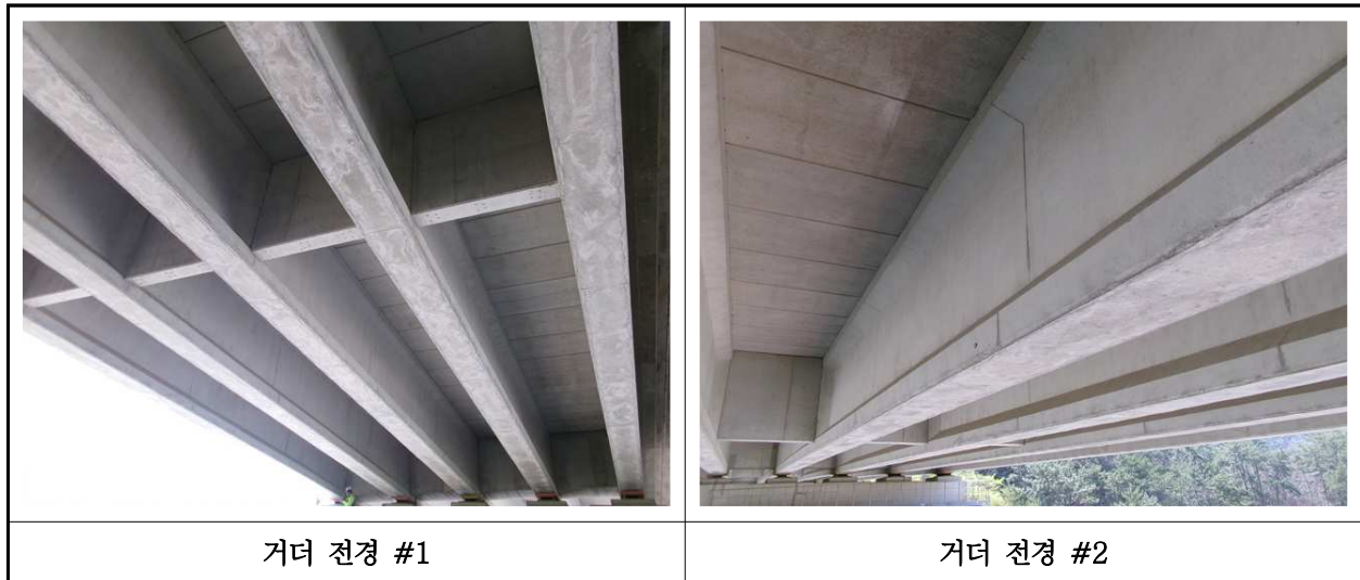
【사진 5.3.4】 거더 전경
