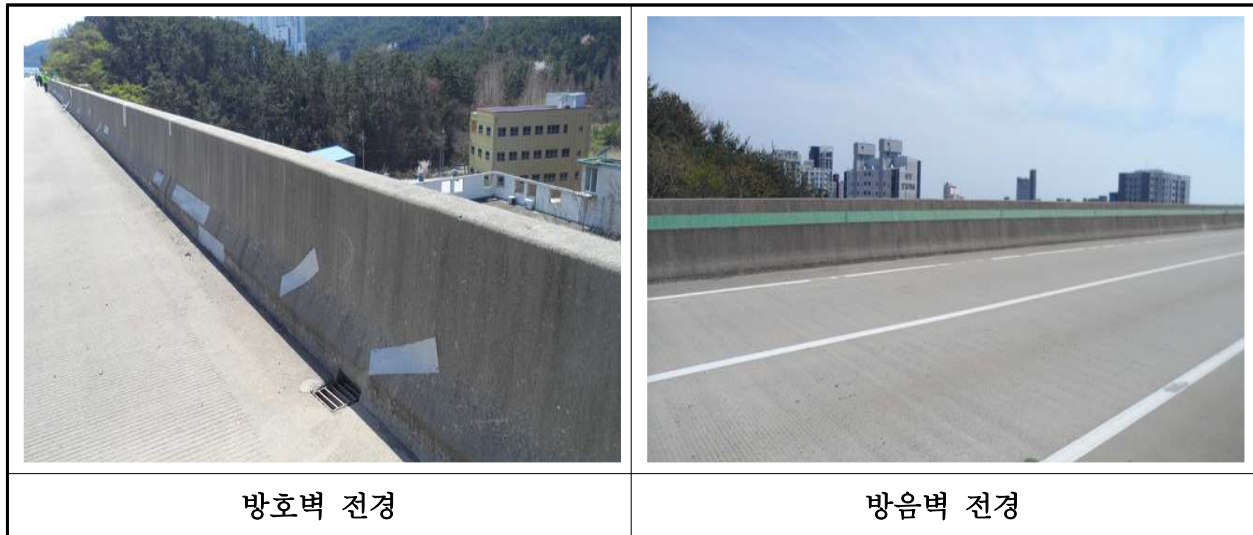
【사진 5.3.24】 방호벽 및 중분대 전경
