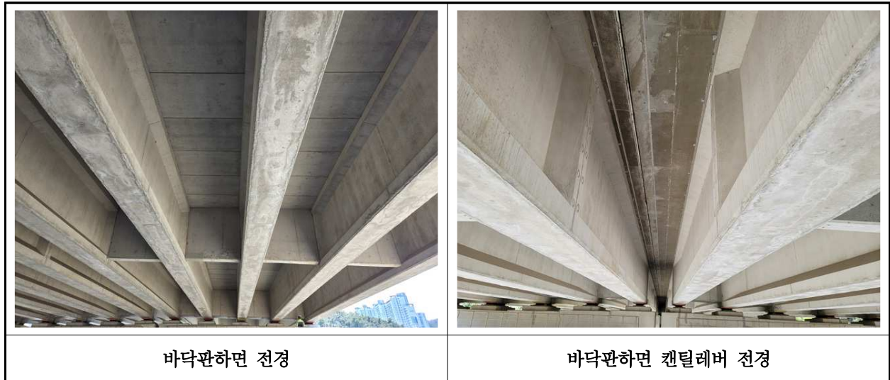
【사진 5.3.2】 바닥판하면 전경
