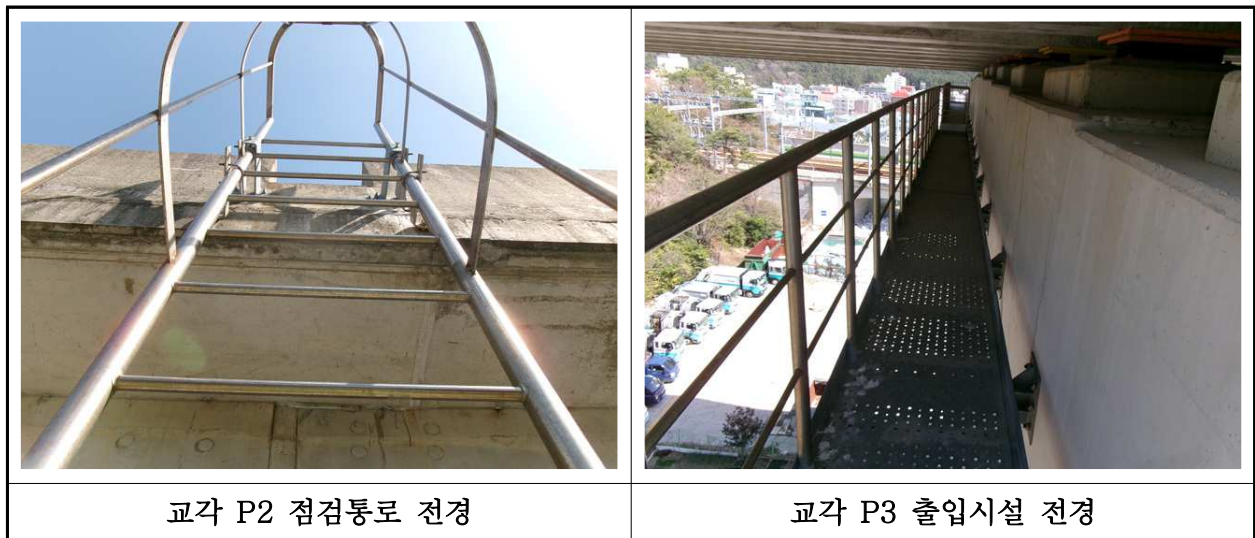
【사진 5.3.26】 교량 점검시설 전경
