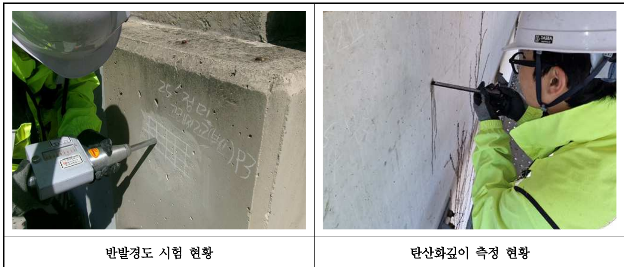
【사진 5.4.1】 콘크리트 내구성조사 현황
