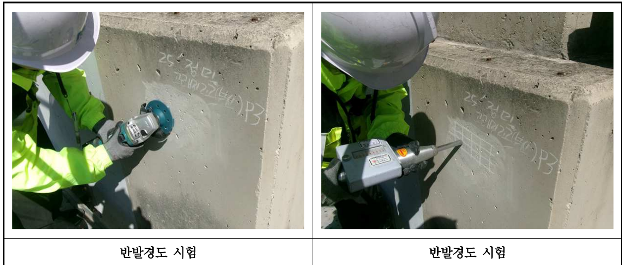
【사진 5.4.2】 반발경도시험 현장사진
