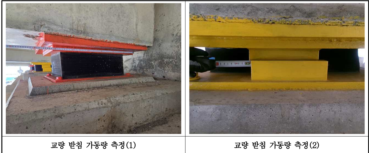
【사진 5.3.16】 교량받침 이동량 측정
