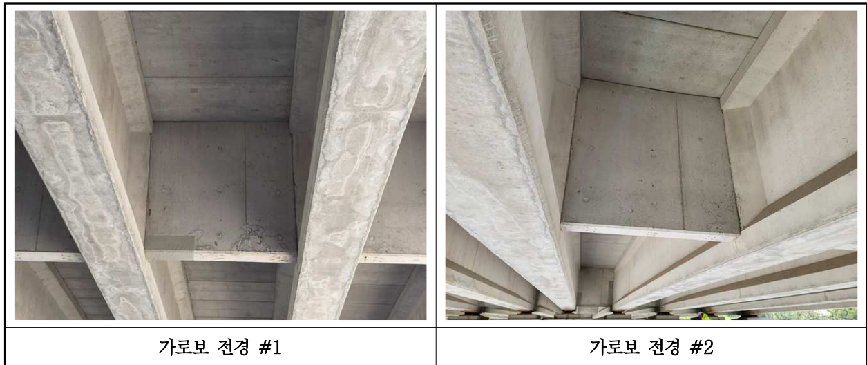
【사진 5.3.6】 가로보 전경
