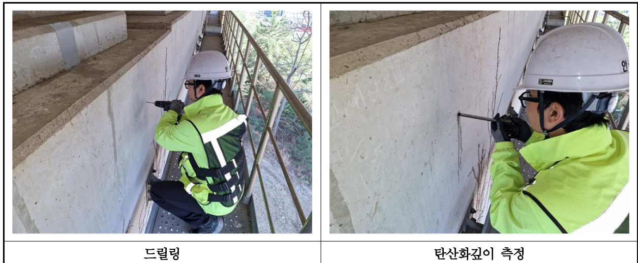
【사진 5.4.3】 탄산화 깊이 측정 현장사진
