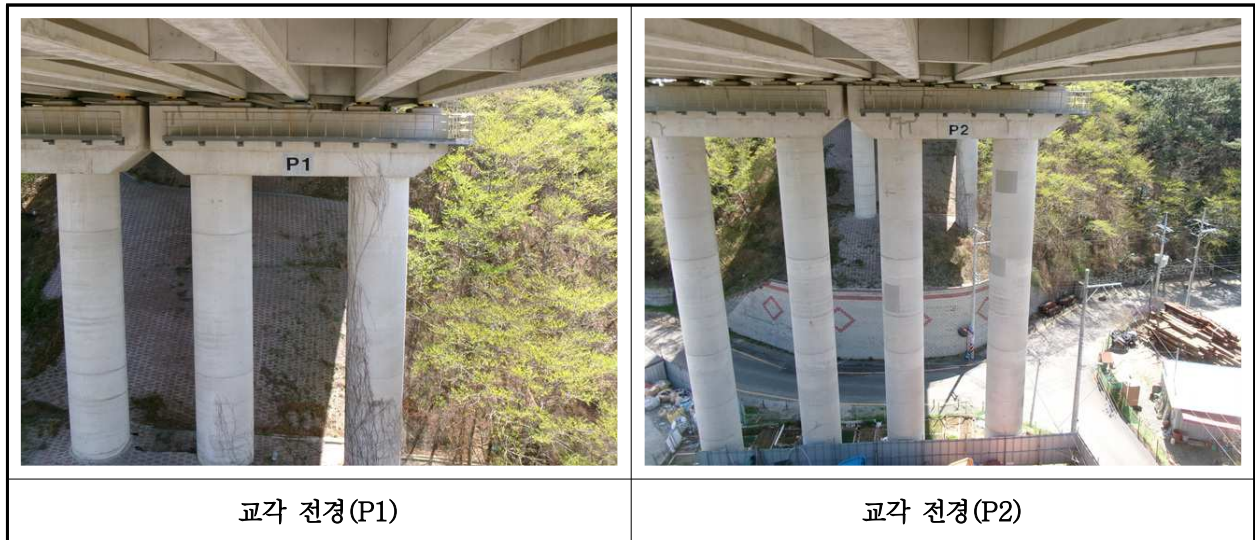
【사진 5.3.10】 교각 전경
