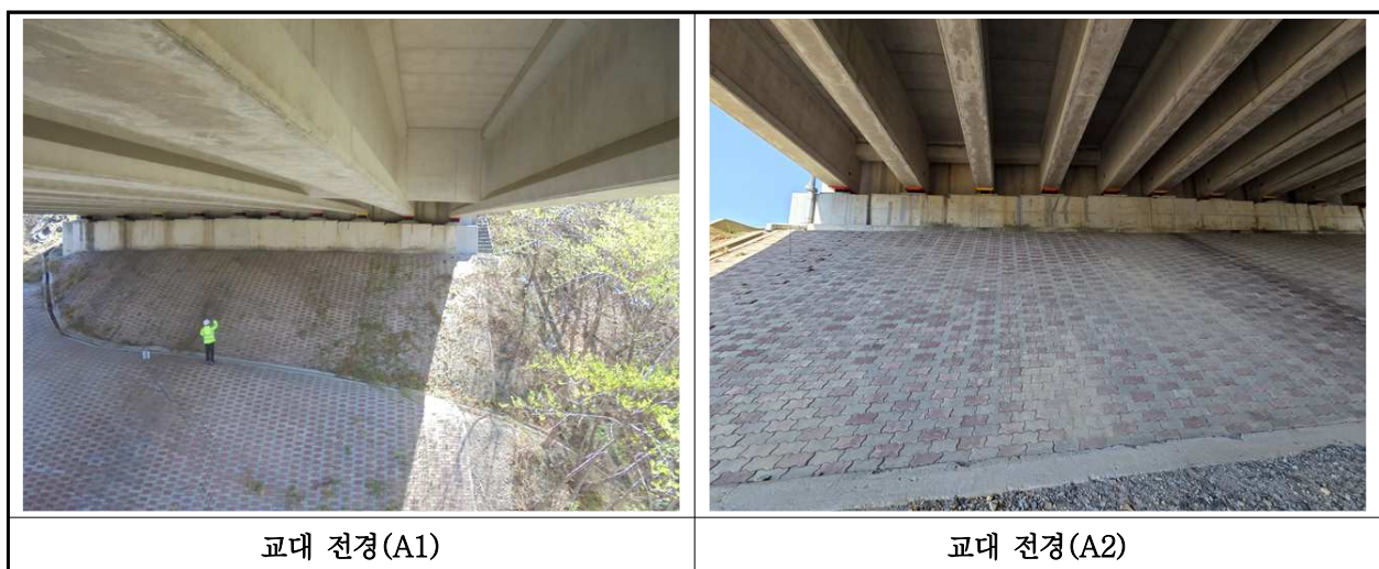
【사진 5.3.8】 교대 전경
