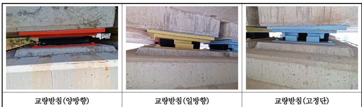
【사진 5.3.13】 교량받침 전경
