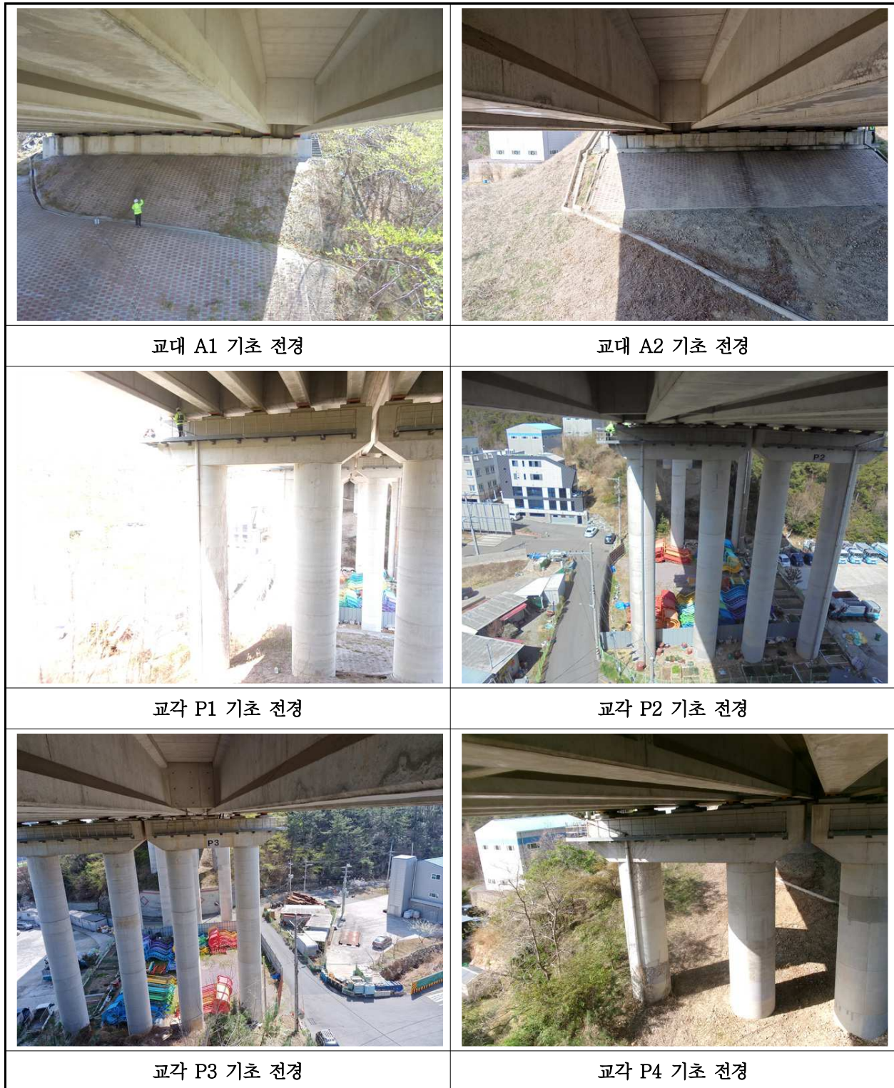
【사진 5.3.12】 기초 전경
